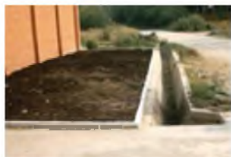
Бетонный лоток
