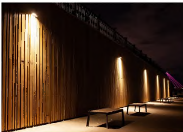
Илл. 4.1.14. ОБОРУДОВАНИЕ ДЛЯ ОСВЕЩЕНИЯ ПОДПОРНЫХ СТЕНОК
