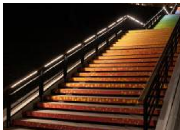
Илл. 4.1.18. ОБОРУДОВАНИЕ ДЛЯ ОСВЕЩЕНИЯ ОРГАЖДЕ-НИЙ И ЛЕСТНИЦ
